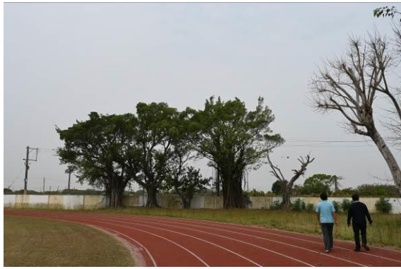
榕樹疑似罹患褐根病，需移除已枯死植株並斟酌是否醫治現存樹木
